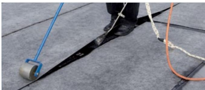
SICOTEC® ist einsetzbar als erste Lage im zweilagigen Systemaufbau von biegeweichen und schwingungsanfälligen Dachkonstruktionen in der Anwendungskategorie K1 und K2.
